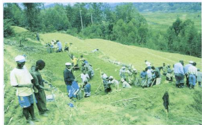
Le projet du Millénaire au Rwanda : mise en œuvre d'un canal d'irrigation et de champs en terrasse
